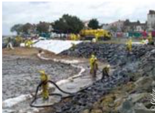
Chantier de nettoyage mécanique sur enrochement
