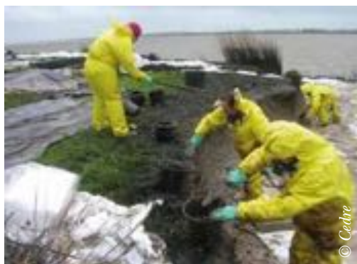
Chantier de nettoyage manuel
