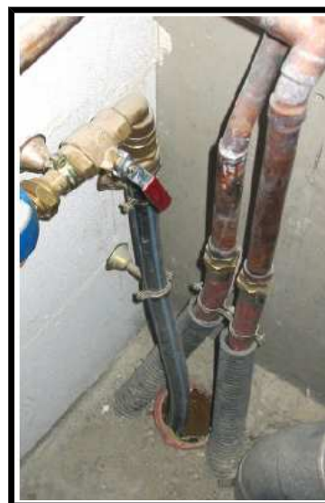
Calfeutrage des entrées de réseaux
