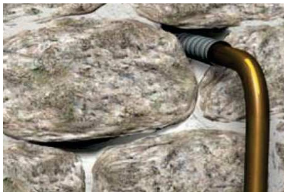
Situation initiale avant colmatage
