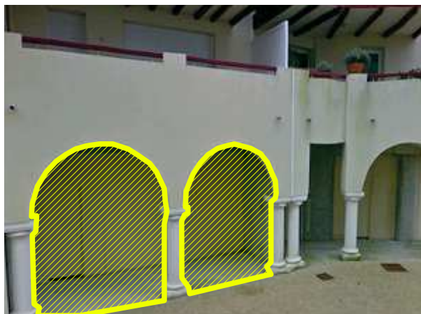
Obturation d'une travée de galerie
