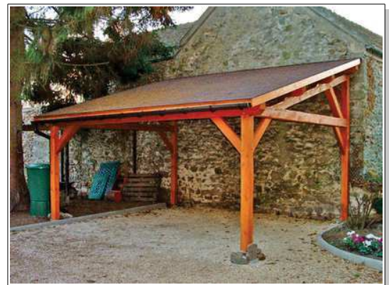
Abri de protection accolé à bâtiment (adjonction)
