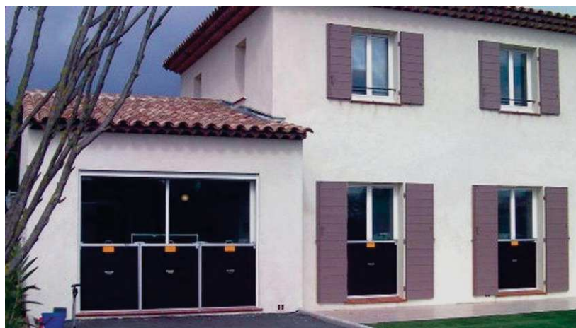
Exemple de protections des ouvertures
