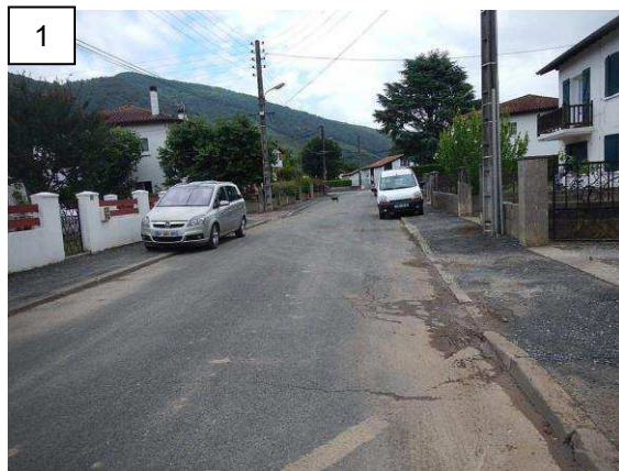
Traces de la crue rue Urgain
