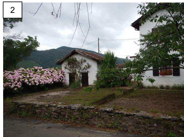
Une des maisons impactée chemin de Sainte-Eulalie
