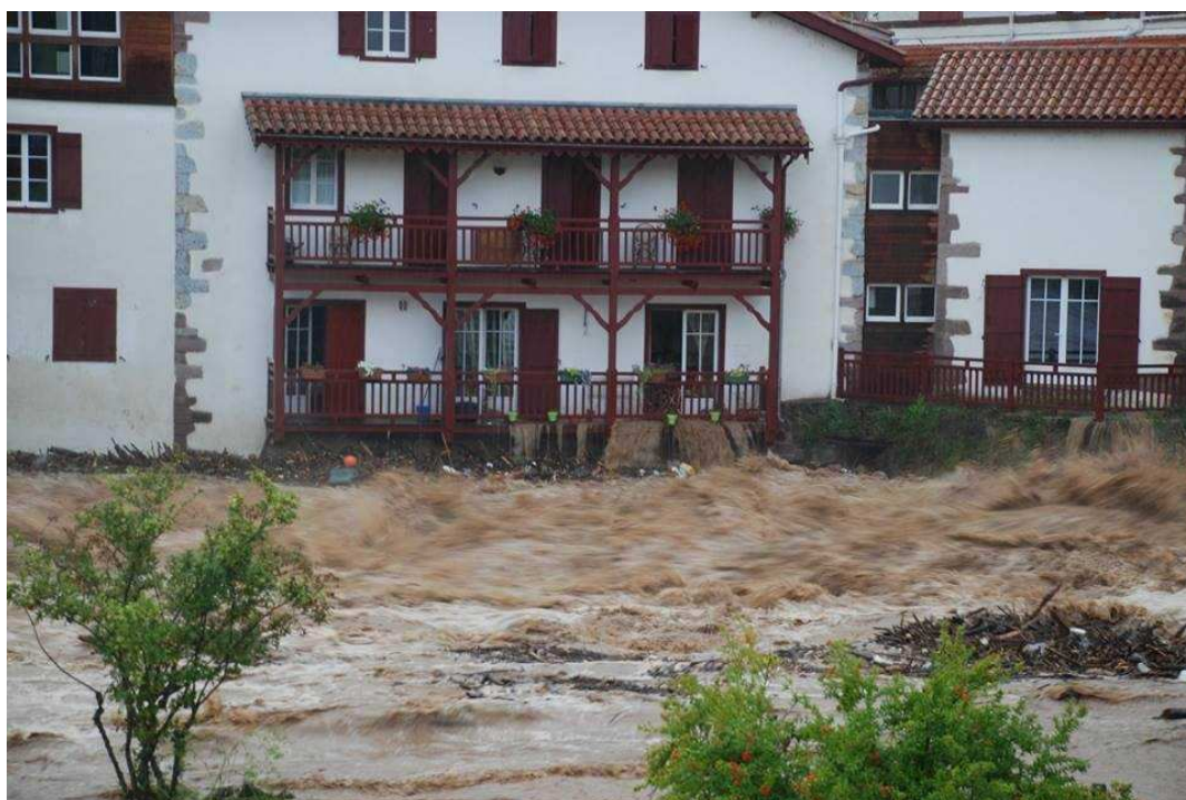
Aval de la RD933 - Nive de Béhérobie
