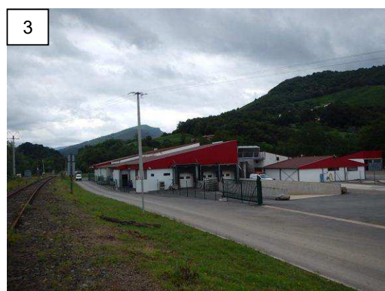
3 Abattoir – repère de crue SLA03
