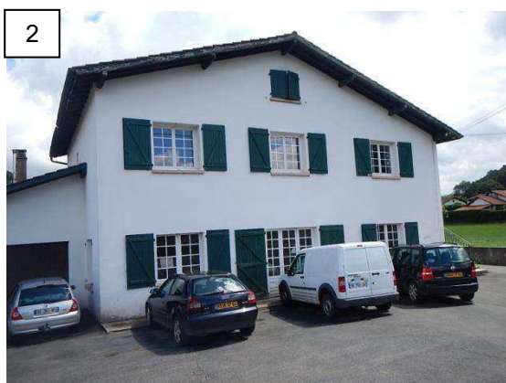
Bâti parcelle 711 en amont de la RD15 – repère de crue UNA01
