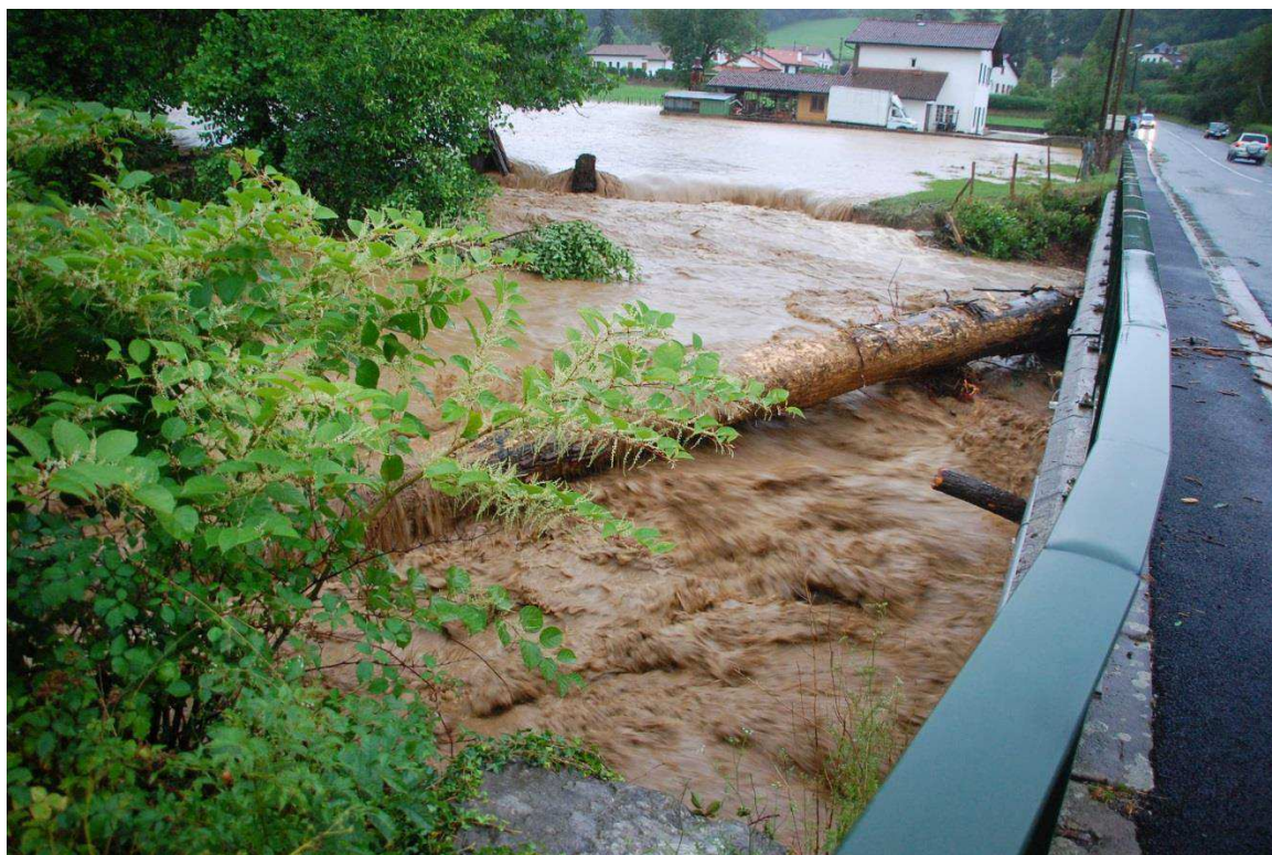
Embâcle au droit du pont de la RD15 / Route d’Ascarat – Nive d’Arnéguy
