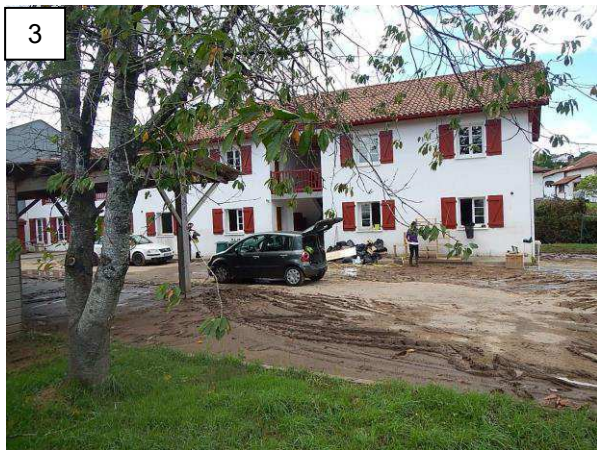
Résidence impactée : environ 1,3 m d'eau au niveau du mur extérieur – repère de crue UNB03
