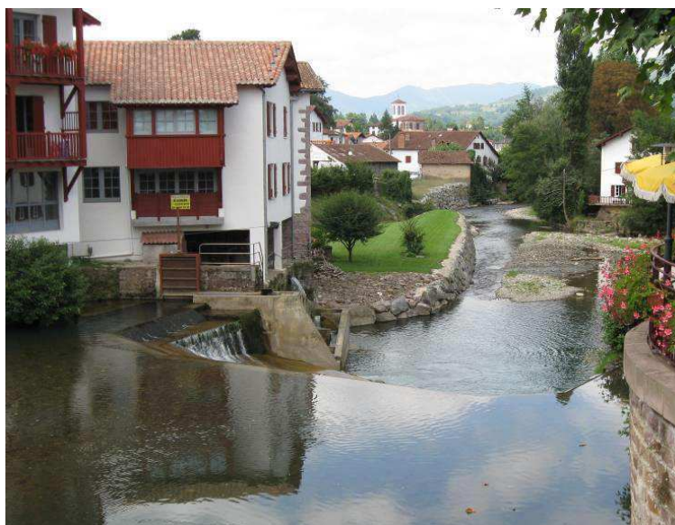
Seuil à l'aval du pont de la RD933 à Saint-Jean-Pied-de-Port
