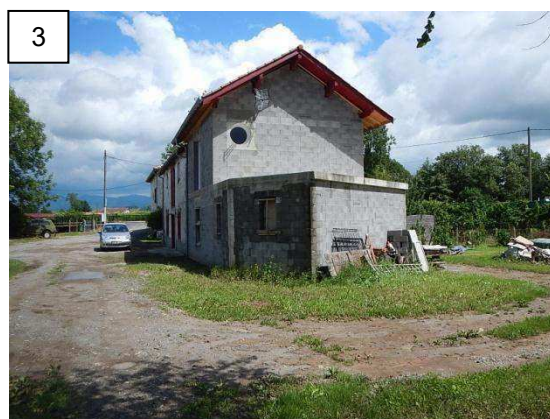
Bâti en aval de la RD15
