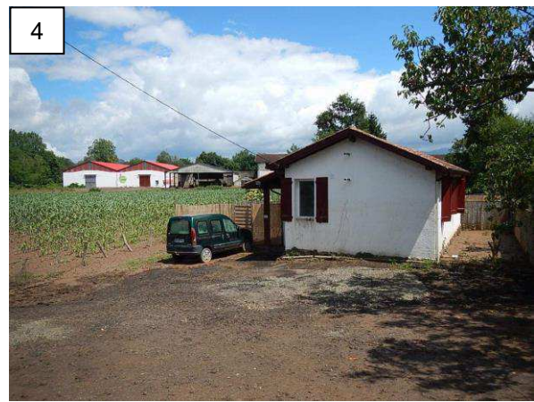
Habitation impactée : environ 1,8 m d'eau au niveau du mur extérieur – repère de crue UNB04
