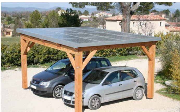
Abri de protection indépendant
