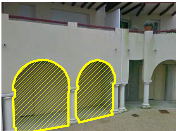
Obturation d'une travée de galerie
