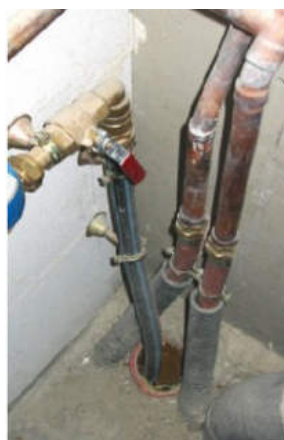
Exemple d'entrées de réseaux à calfeutrer
