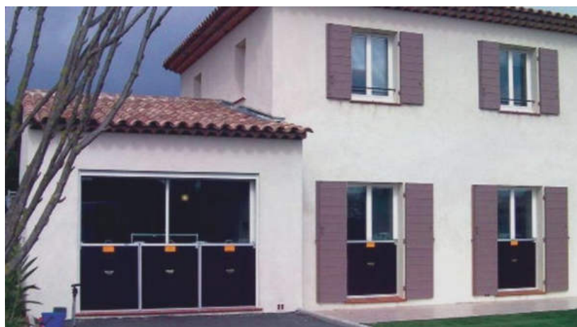
Exemple de protections des ouvertures
