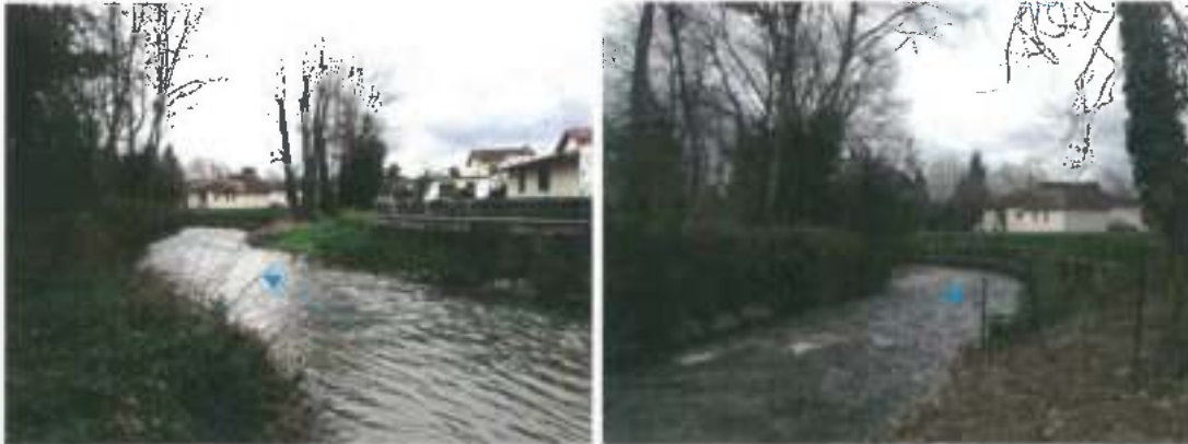
Figure 45 : L'Arriou Merdé – muret rehaussé impasse Foch et merlon en rive gauche
