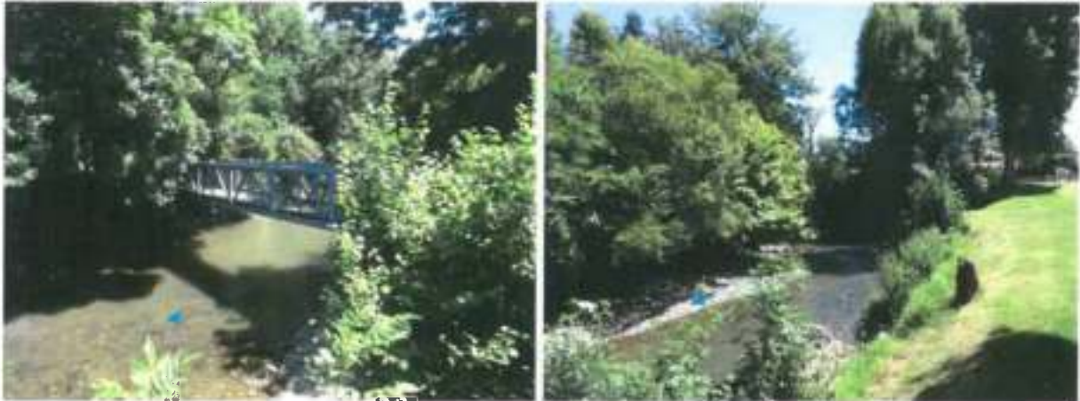
Figure 39 : L'Ousse – passerelle du collège et amont avenue des Lavandières
