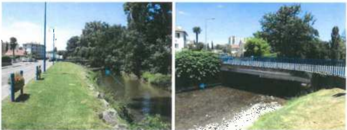
Figure 40 : L'Ousse – aval avenue des Lavandières et pont rue de l'Ousse
