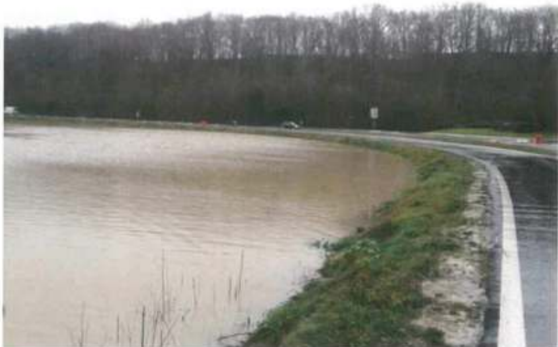
Figure 48 : L'Arriou Merdé en crue en janvier 2014 en amont de la rocade (source : commune de Bizanos)
