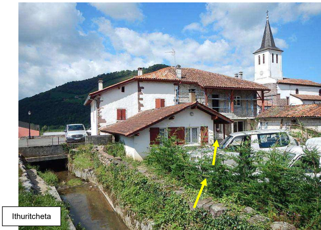
Figure 25 : Zoom sur le bâti, le dalot et le muret rive droite : l'eau est passé par-dessus le muret, a pénétré dans la cours puis dans l'habitation (cf. flèches)
