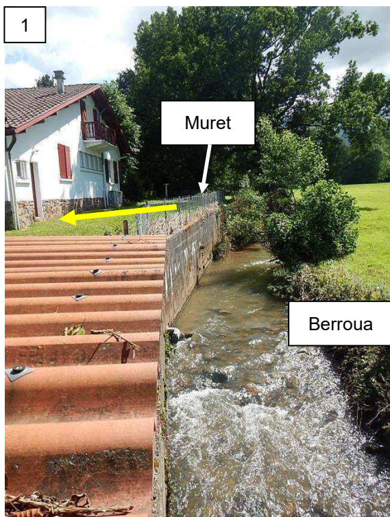
Débordement au droit de la maison « Gure Amentsa » - dépôt sur le grillage par-dessus le muret en rive droite du Berroua (vue de l'aval)
