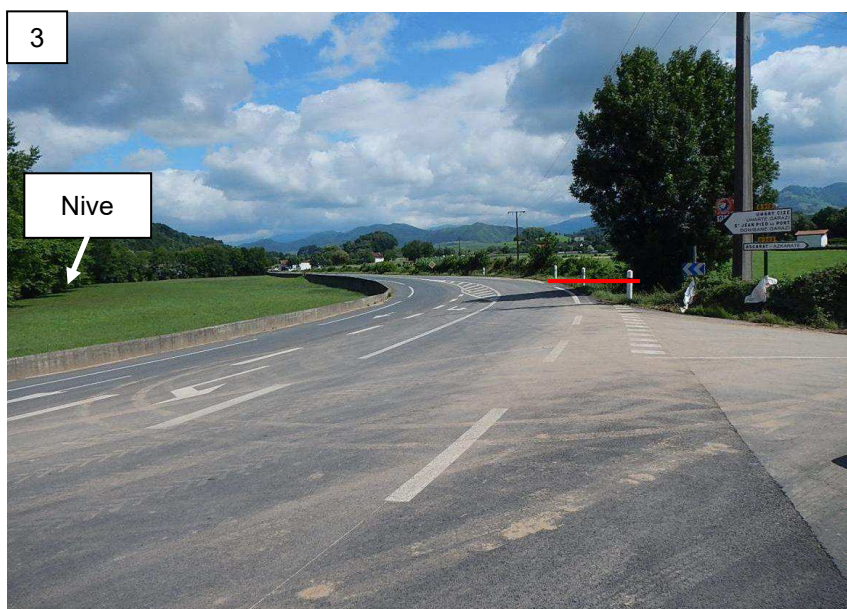
RD918 à la confluence entre le Berroua et la Nive - d'après Monsieur le Maire d'Ascarat, l'eau a atteint la partie supérieure des plots signalant l'intersection (en rouge)
