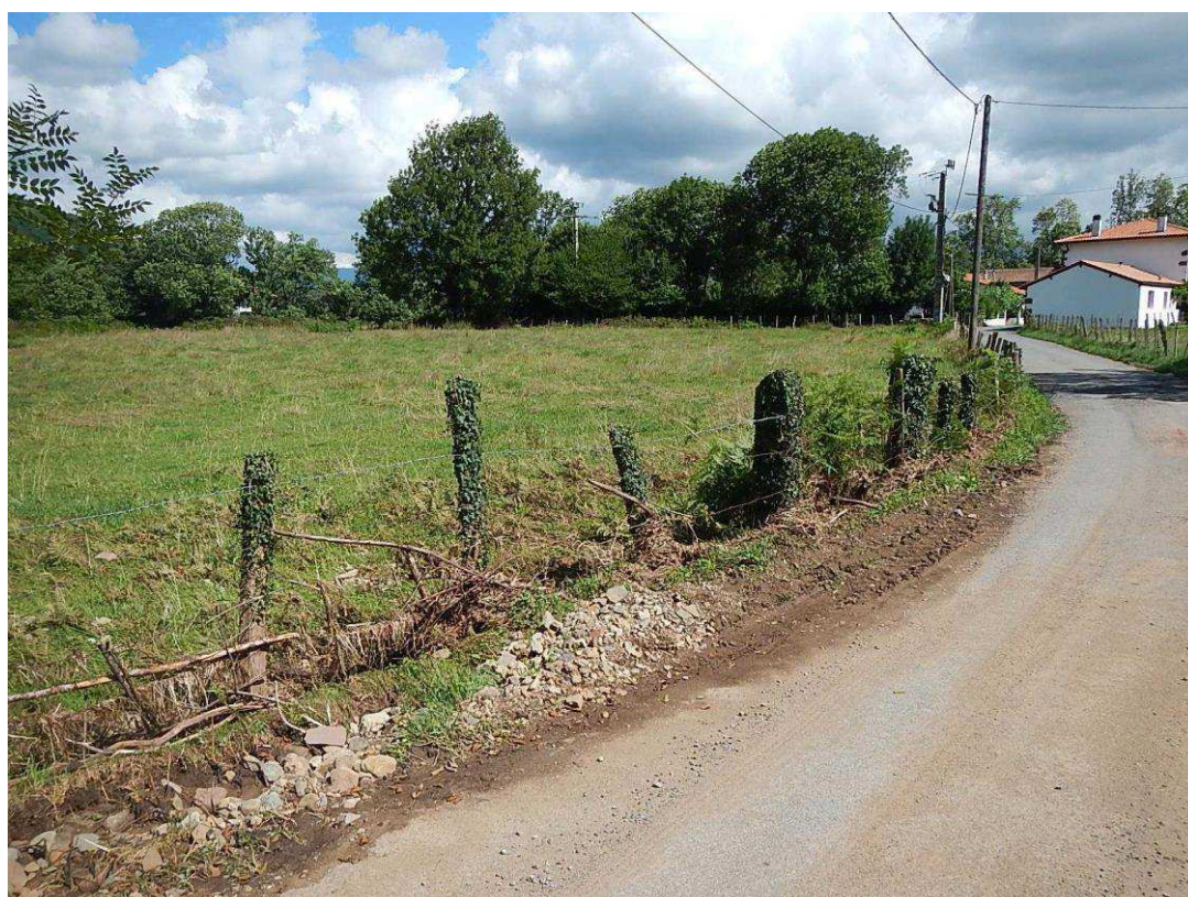
Trace de la crue chemin Bassaburu – Berroua
