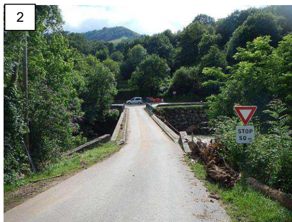
Pont de la Nive entre Ispoure et Ascarat
