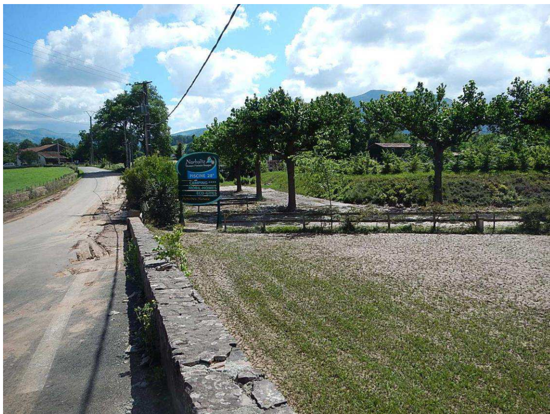
Trace de la crue au droit du camping Narbaitz et de la RD303 – Confluence de la Nive et du Berroua
