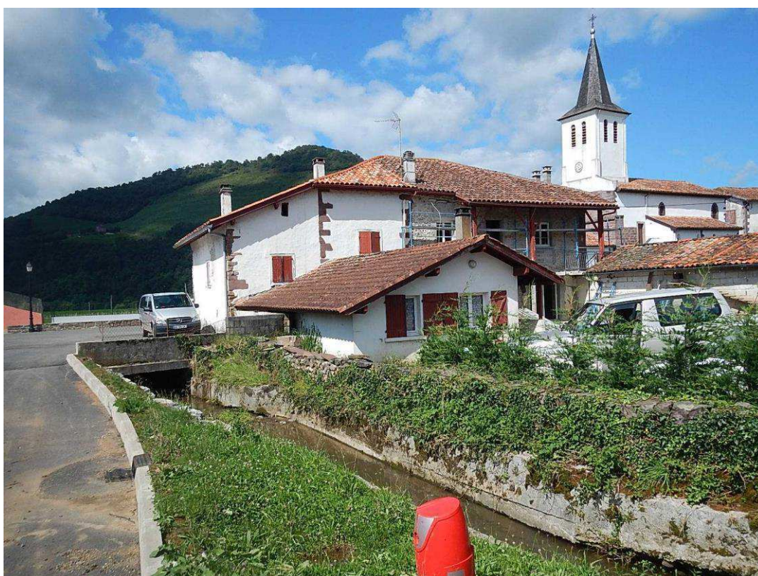
Bâti impacté au droit de la place de l'église et du fronton – Ithuritchéta
