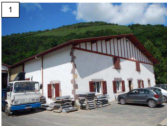
Etablissement Berho, environ 20 cm d'eau dans les bureaux pendant la crue – repère de crue ANI01
