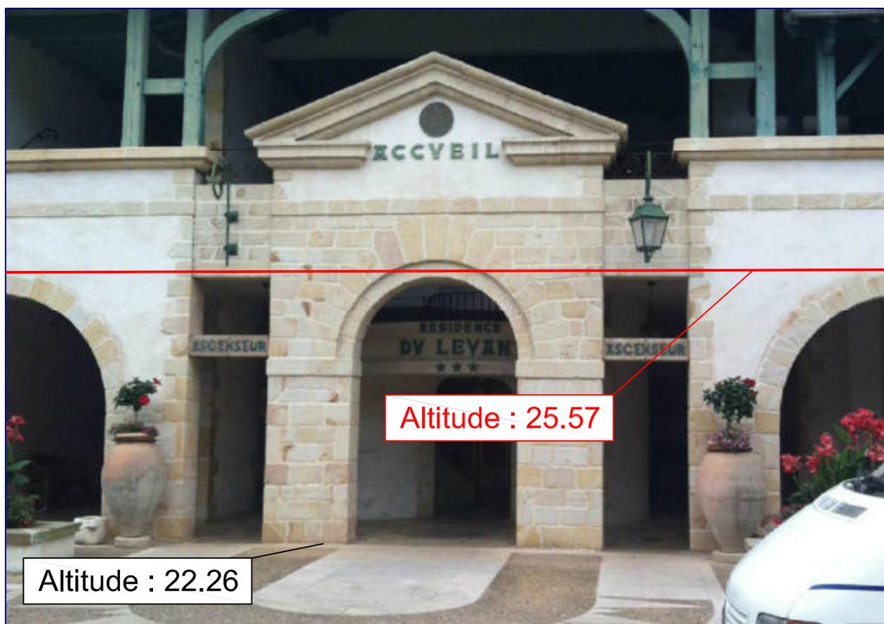
Le nivellement est rattaché au système NGF-IGN69.
