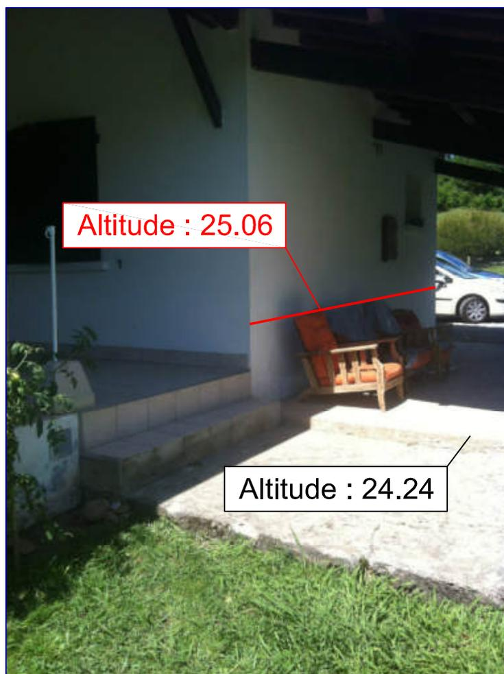
Le nivellement est rattaché au système NGF-IGN69.
