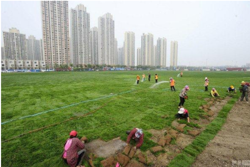
Travaux de réhabilitation du site (Source : droit réservé)
