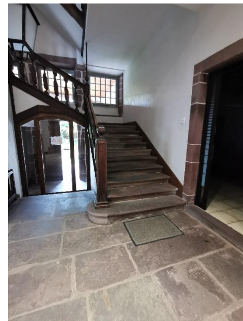
Dallage en pierre et première volée d'escalier mairie
