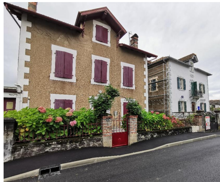
Point de vigilance sur les ravalement, enduit à texture à grain et couleur d'origine à ne pas remplacer au profit des enduits lisses et blancs.
