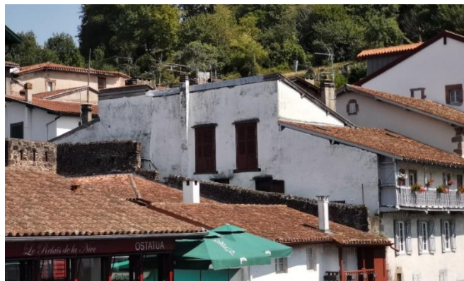
Portion d'enceinte sur lesquelles sont appuyées des maisons.
