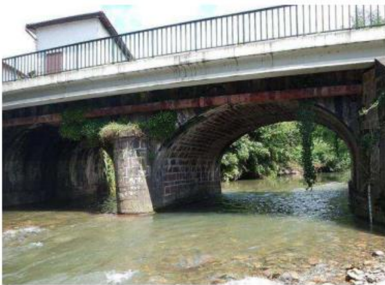
Pont de la RD933 entre Saint-Jean-Pied-de-Port/Ispoure
