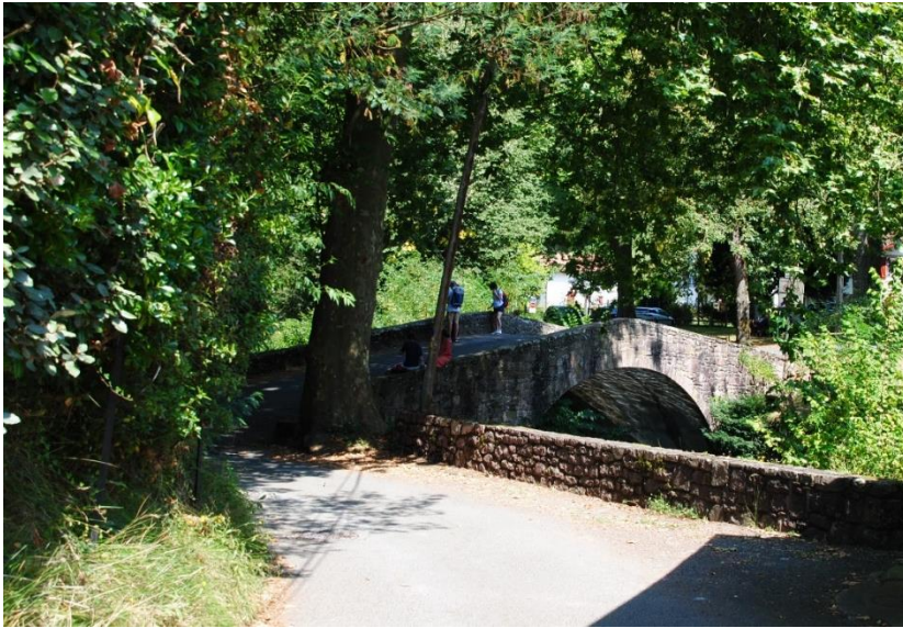
Le pont d'Eyheraberry, qui passe parfois pour remonter à l'époque antique, évitait le bourg au sud est. Un espace paysager de qualité
