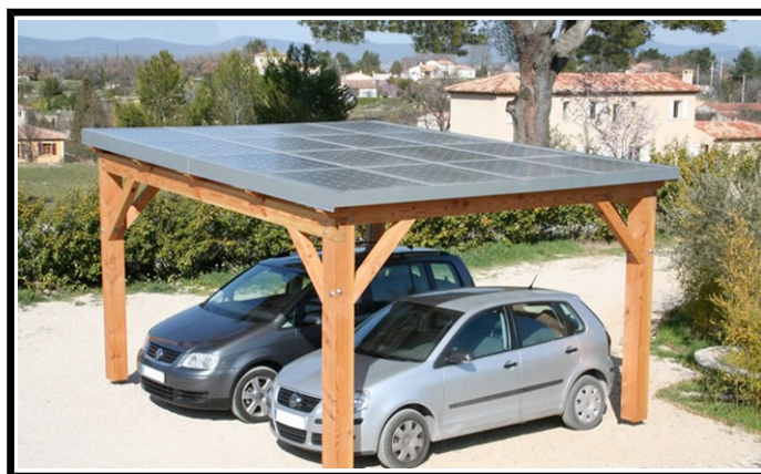
Construction annexe non contiguë
