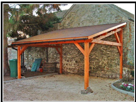
Construction annexe adossée
