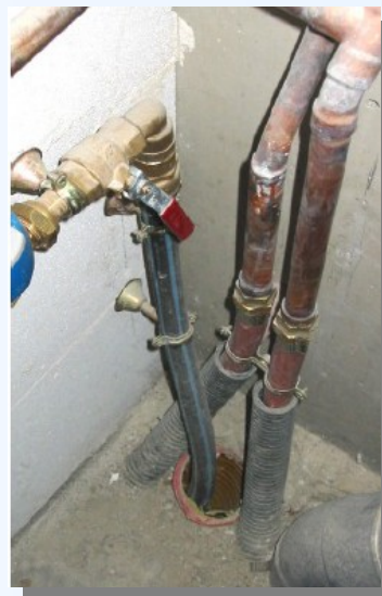
Calfeutrage des entrées de réseaux
