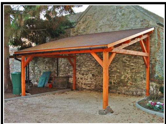
Construction annexe adossée
