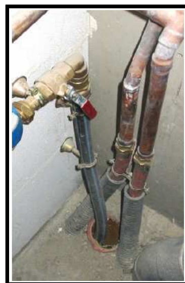
Calfeutrage des entrées de réseaux
