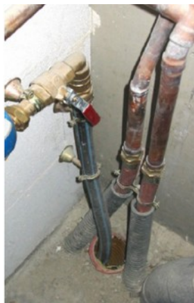
Exemple d'entrées de réseaux à calfeutrer
