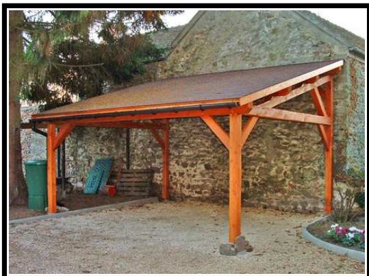
Construction annexe adossée
