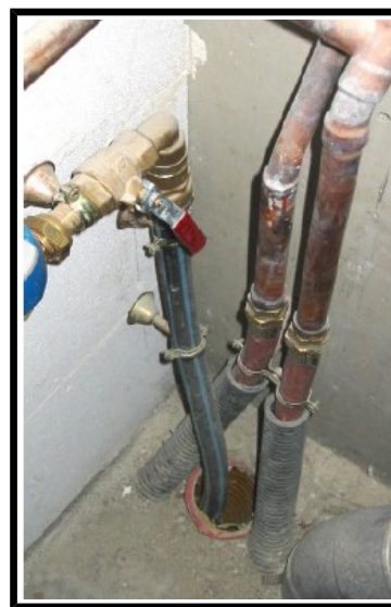
Calfeutrage des entrées de réseaux
