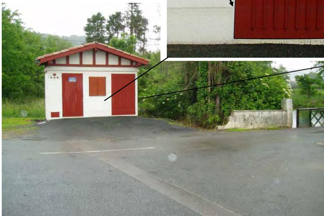
**Vue vers l'amont sur le poste électrique. La crue y a laissé une trace nette (flèches noires). A gauche d'une des portes (flèche inclinée), elle est à 0.32m du sol.**
