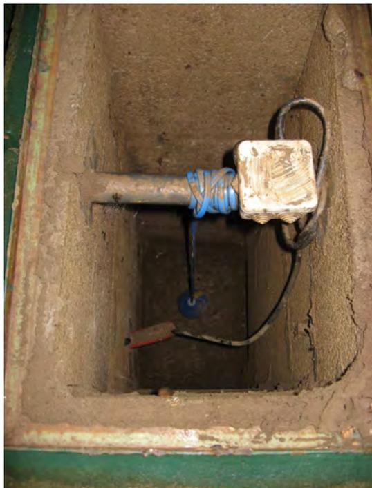
*Alarme type interrupteur à mercure (poire) placée à 1.40 m avant débordement. Vue intérieur*
