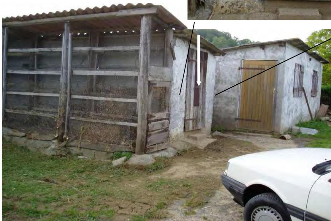
**Sur la porte, la crue a déposé une laisse nette (flèches), à 1.16m au-dessus de la marche.**
