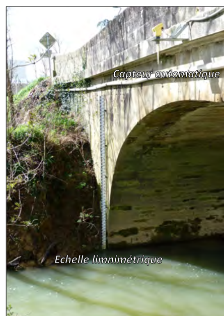
Une station hydrométrique est constituée d'une échelle de référence et d'un capteur automatique
