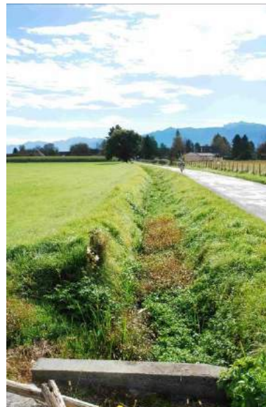
Fig. 17. Bras de Mielles issu du réseau pluvial en aval du quartier Pondeilh
