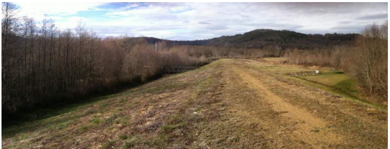
Fig. 10. Barrage écrêteur de crues des Mielles
