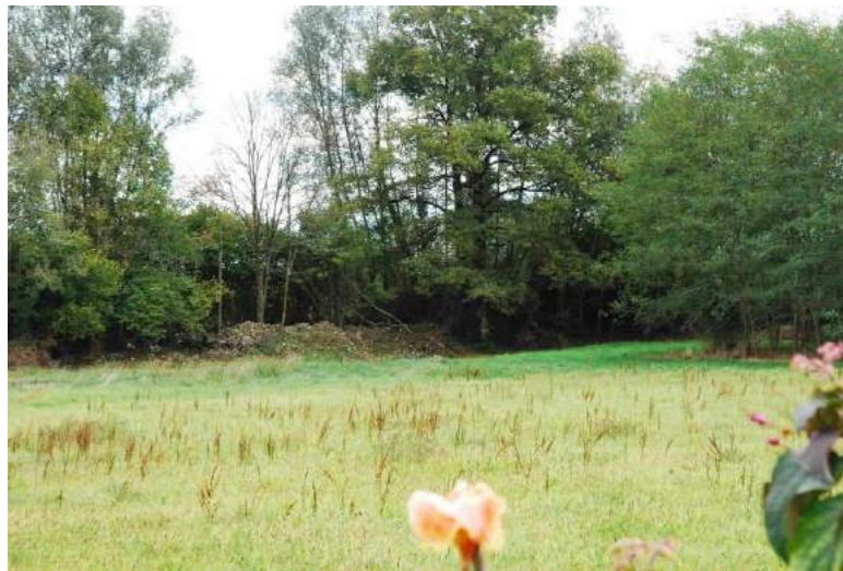
Fig. 23. Partie endiguée de la Miellotte en aval du bourg de Moumour (lotissement du pont du Vert)
