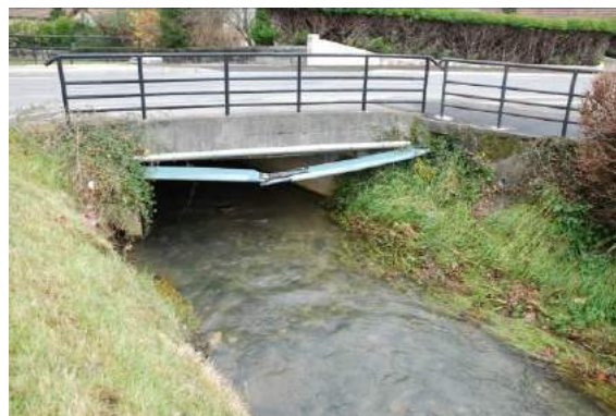
Fig. 15. Ouvrage de franchissement de la rue de Barcus
