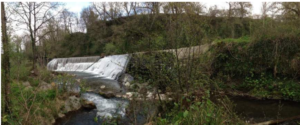
Fig. 33. Seuil d'alimentation de la centrale électrique Bessonneau
