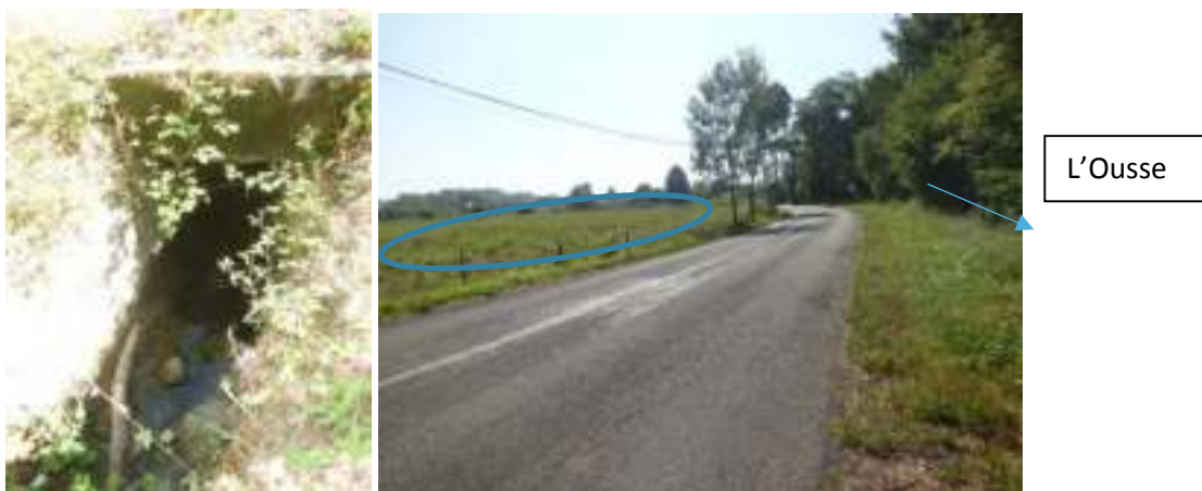
Figure 44 : L'Arriou – Ouvrage RD213 et pâture inondable à la confluence de l'Ousse
