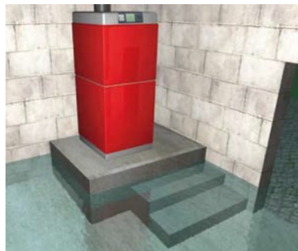
Mise hors d'eau par surélévation
