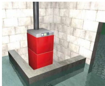
Protection par disposition étanche
