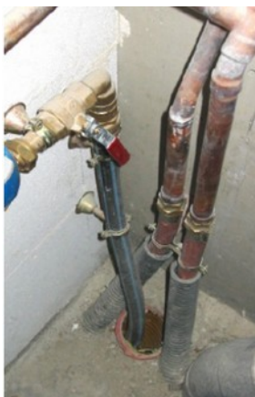
Exemple d'entrées de réseaux à calfeutrer
