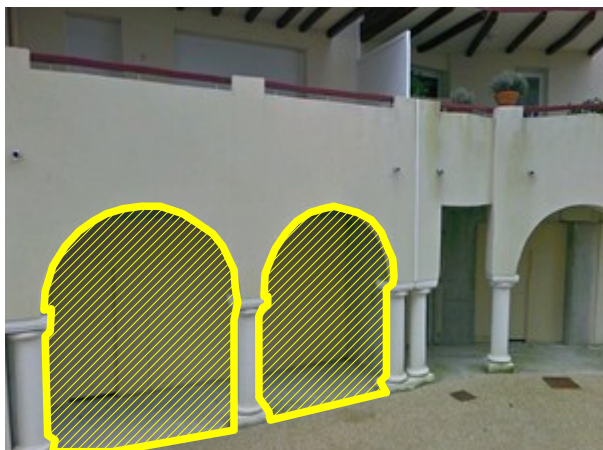
Obturation d'une travée de galerie
