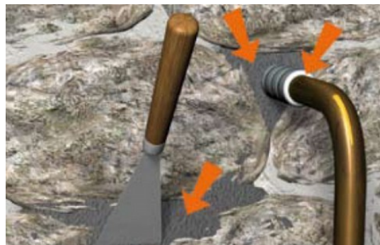
Situation après travaux de colmatage
