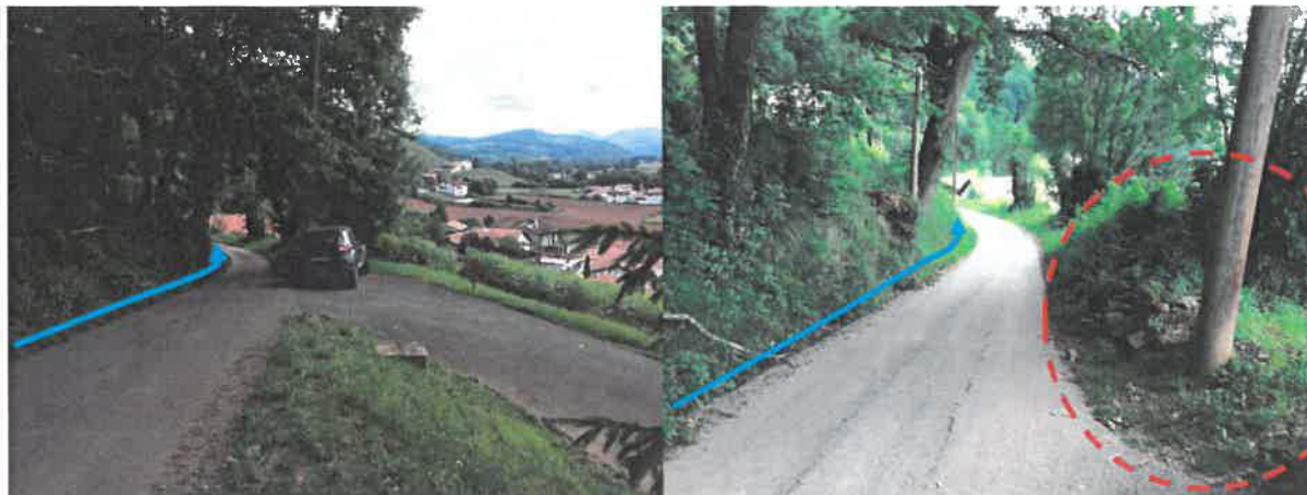
Figure 7 : Photos de l'élément microtopographique (en rouge) et représentation du fossé d'écoulement (en bleu)
