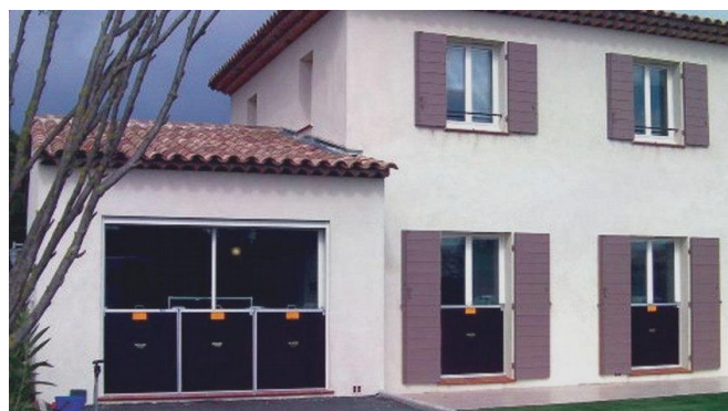
Exemple de protections des ouvertures
