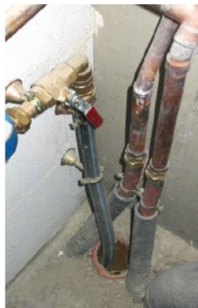
Exemple d'entrées de réseaux à calfeutrer
