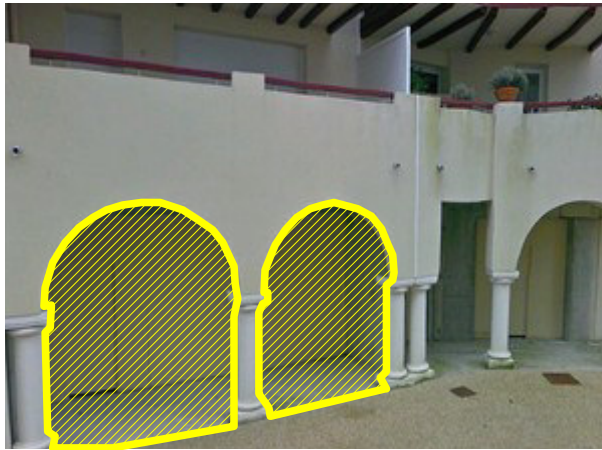
Obturation d'une travée de galerie
