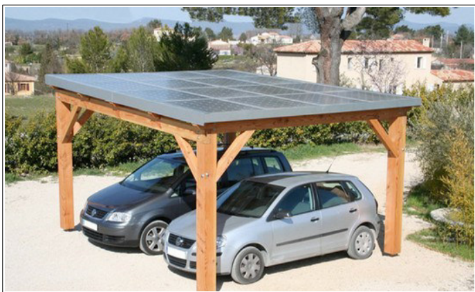
Abri de protection indépendant
