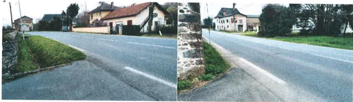
Fig 4 : Exemple de sorties dangereuses qui resteront dangereuses sans aménagement sur l'actuelle RD11
