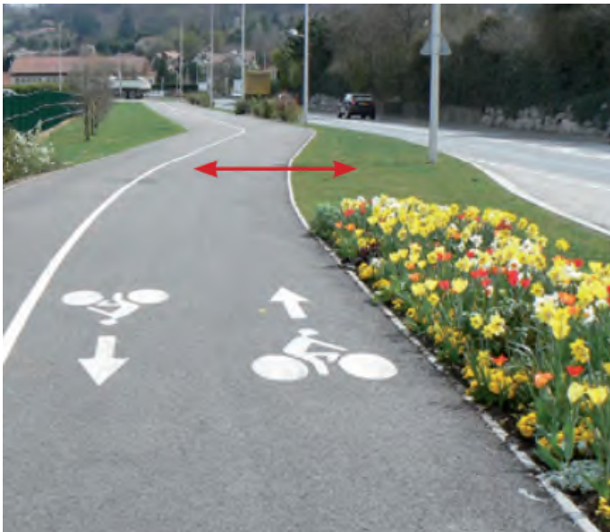
Exemple de séparation par végétation du cheminement piéton/cycle et de la voie
