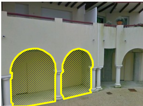
Obturation d'une travée de galerie
