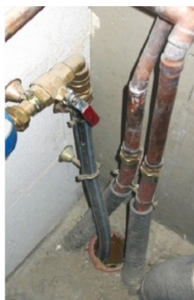
Exemple d'entrées de réseaux à calfeutrer
