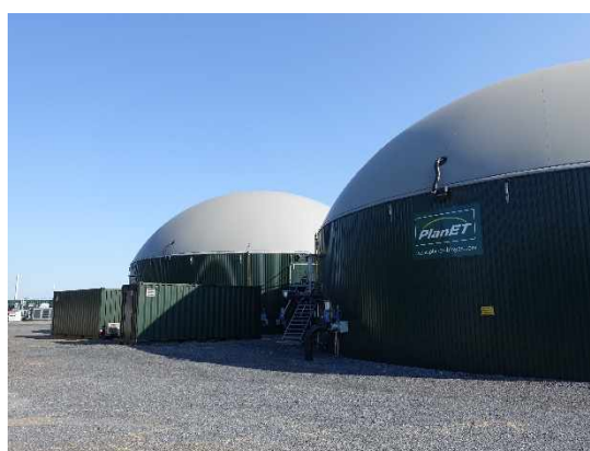
Digesteur et post digesteur ARTIFEX 2023
