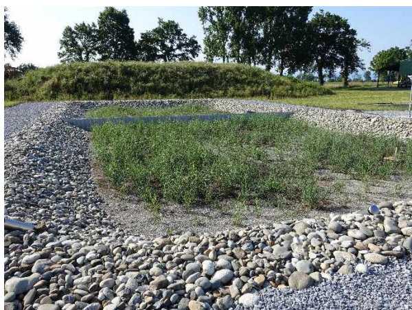
Filtre à roseaux ARTIFEX 2023
