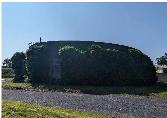
Cuve à lisier – GAEC EDELWEISS ARTIFEX 2023
