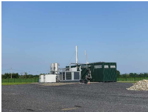
Voie de circulation autour de l'épuration et de la chaufferie ARTIFEX 2023
