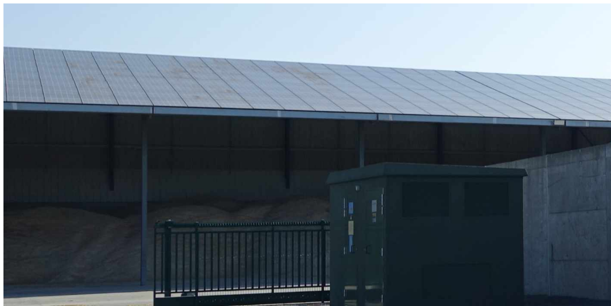
Panneau PV sur la toiture du hangar ARTIFEX 2023
