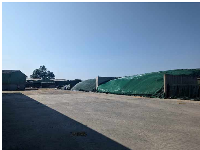
Silos de stockage des CIVEs ARTIFEX 2023
