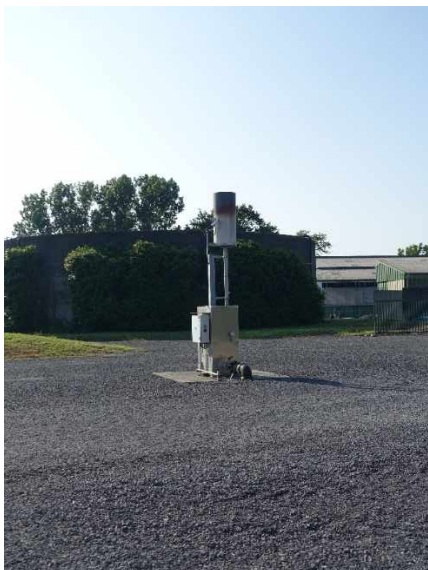
Voie de circulation autour de la torche ARTIFEX 2023
