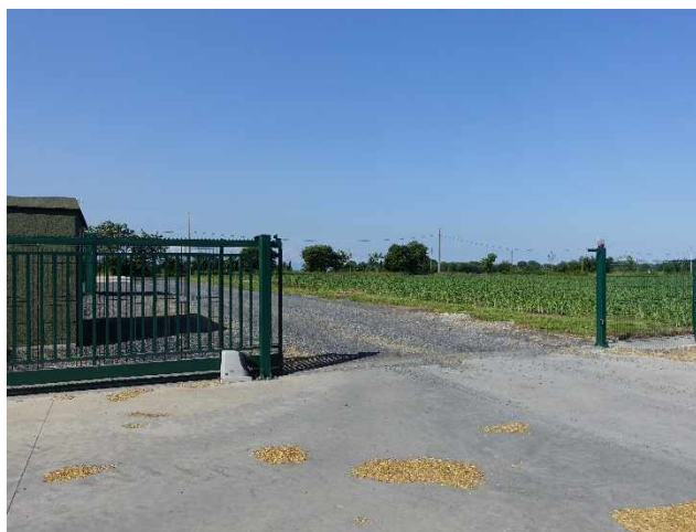
Portail d'accès au site
