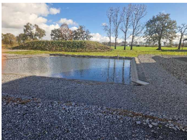
Bassin de tamponnement des eaux pluviales ARTIFEX 2023
