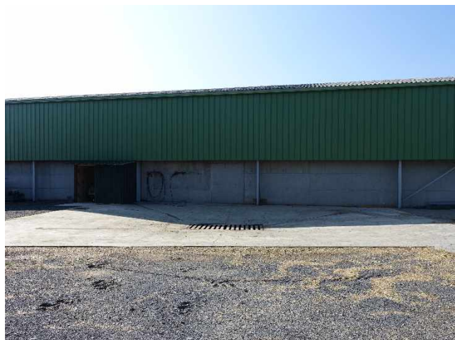
Aire de lavage ARTIFEX 2023
