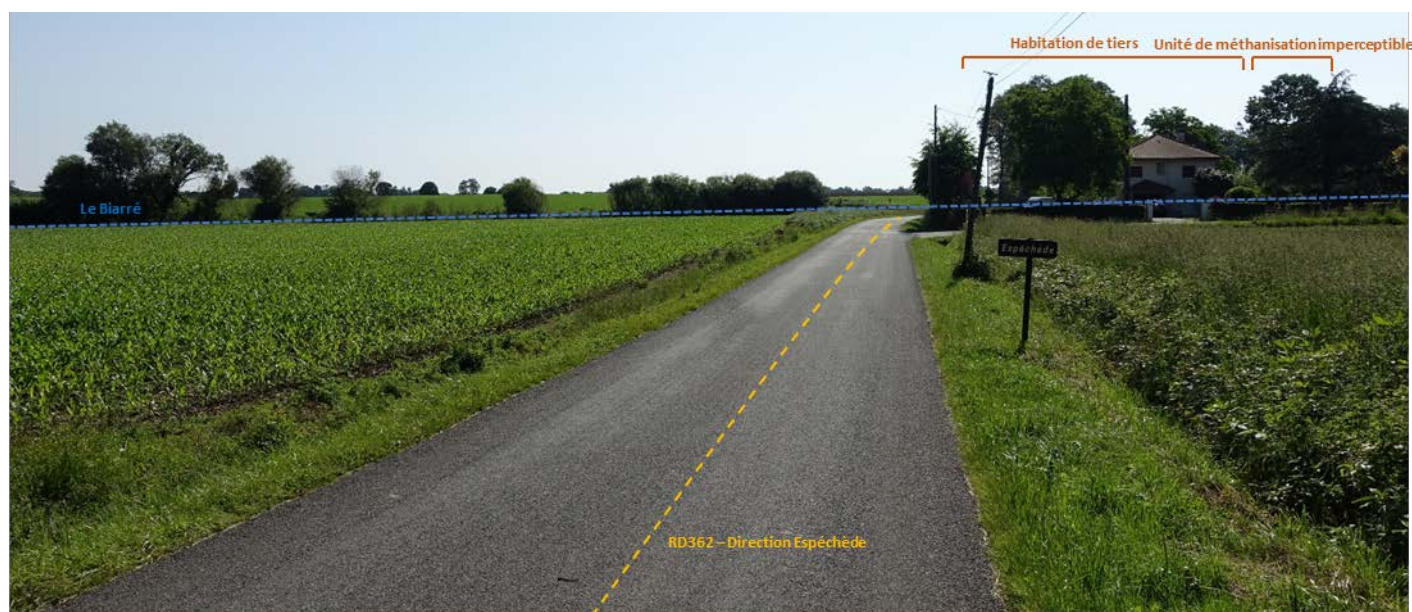
Vue sur l'unité de méthanisation depuis la RD362 à l'Ouest de la commune (PDV 5).
