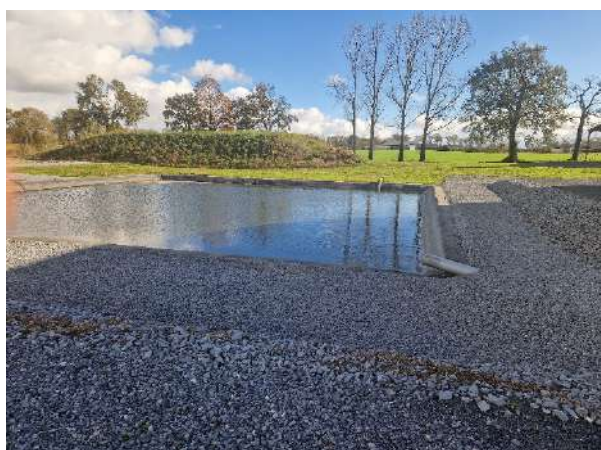
Bassin de tamponnement des eaux pluviales ARTIFEX 2023
