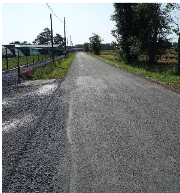
RD 362 au Sud du site Artifex 2023
