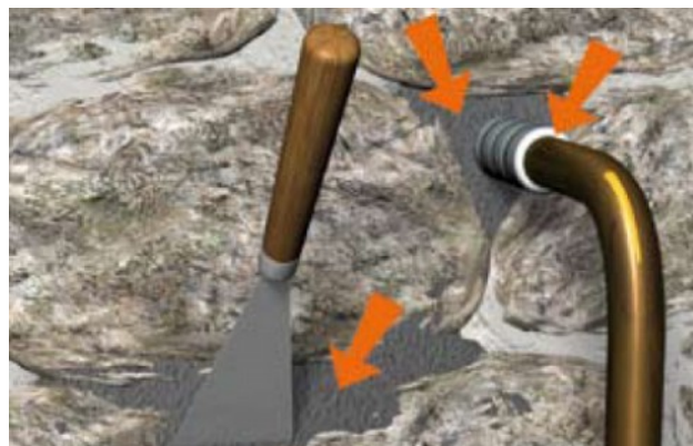
Situation après travaux de colmatage
