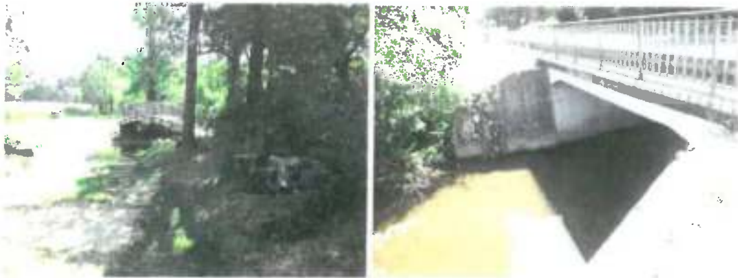
Figure 43 : L'Arriou Merdé - Passerelle Juyou et RD 938
