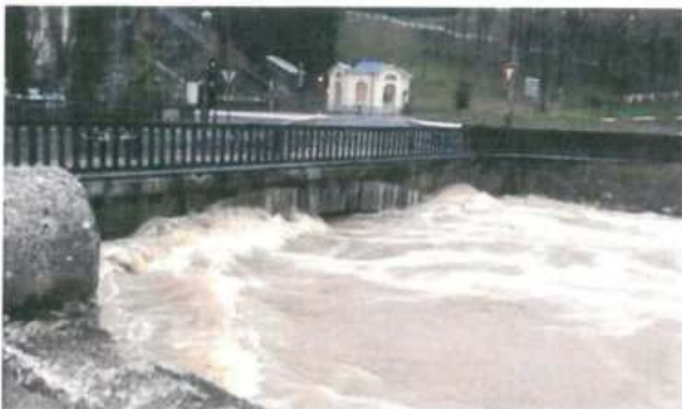
Figure 27 : Pont de l'Ousse rue de la Gare en 2014 (source DDTM64)
