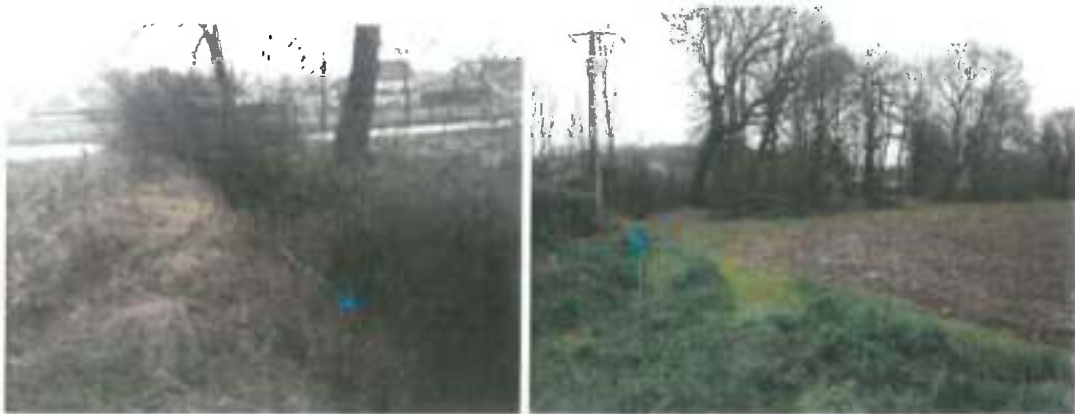
Figure 39 : Fossé Est du Clos Beaumont – coté RD213 et buse de connexion à l'Ousse
