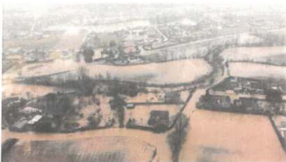
Figure 45 : L'Ousse lors de la crue de janvier 2014 en aval du Château d'Itron (source SDIS64)
