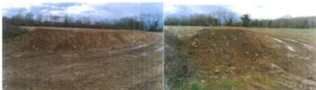
Photos du merlon en construction à Lée
