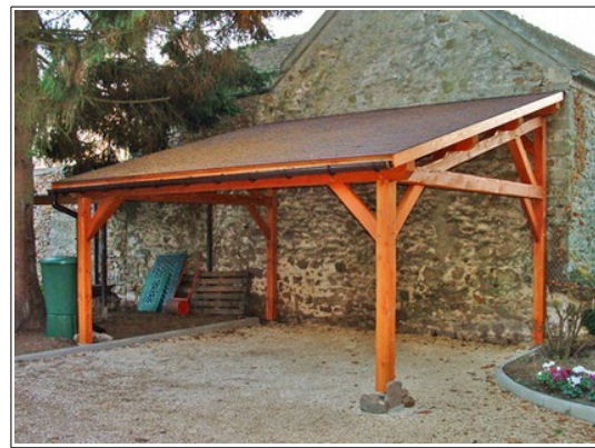
Abri de protection accolé à bâtiment (adjonction)
