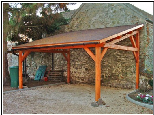
Construction annexe adossée à façade
