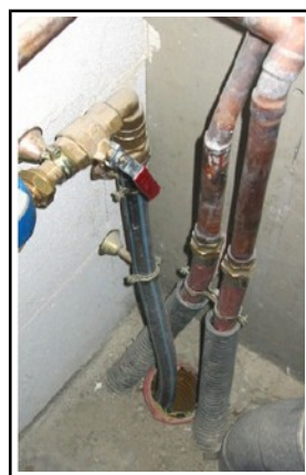
Exemple d'entrées de réseaux à calfeutrer
