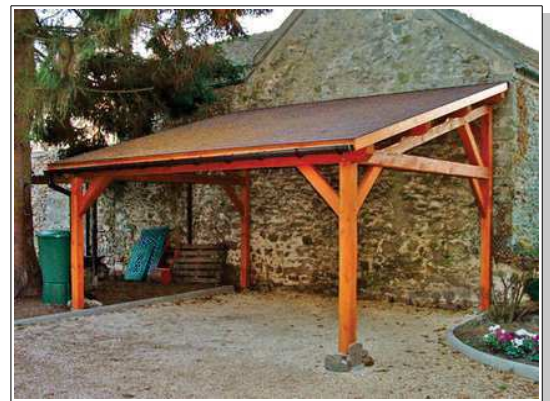
Abri de protection accolé à bâtiment (adjonction)
