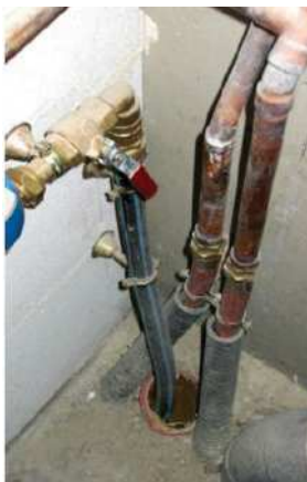
Exemple d'entrées de réseaux à calfeutrer
