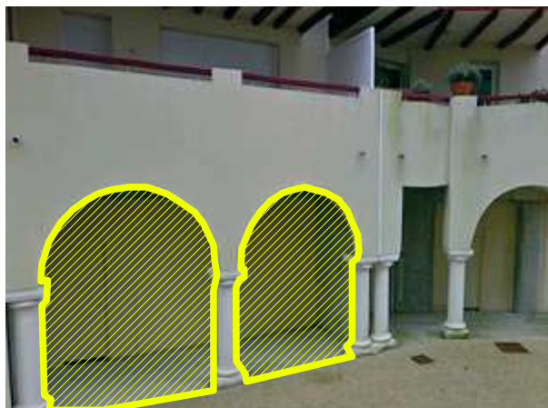
Obturation d'une travée de galerie
