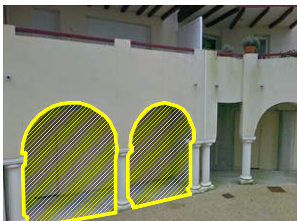
Obturation d'une travée de galerie
