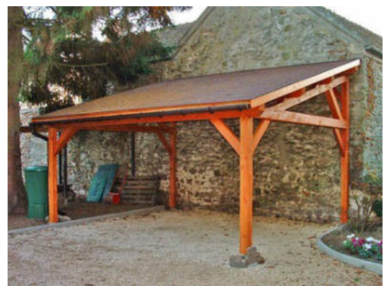
Abri de protection accolé à bâtiment (adjonction)
