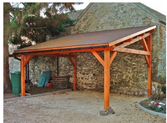
Abri de protection accolé à bâtiment (adjonction)
