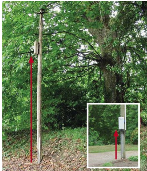
Exemple de mise hors d'eau de compteur électrique
