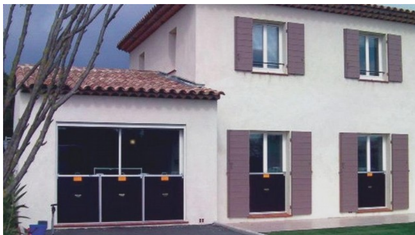
Exemple de protections des ouvertures
