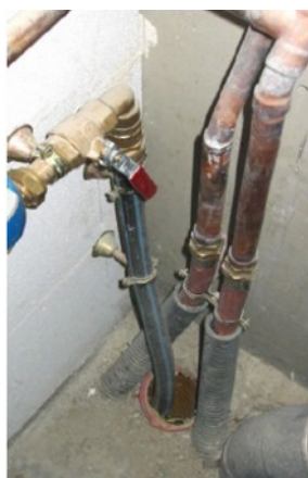
Exemple d'entrées de réseaux à calfeutrer
