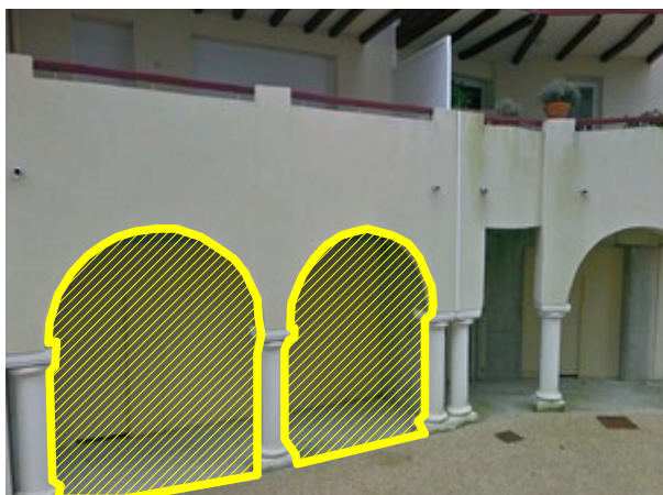
Obturation d'une travée de galerie
